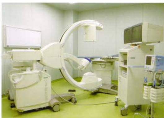
ESWL室(体外衝撃波結石破碎装置)
