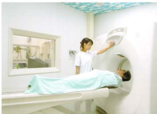
CT室(コンピュータ断層撮影装置)
